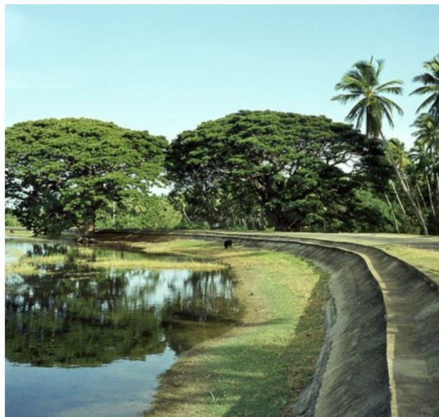
Wasserbassin des Tanksystems
